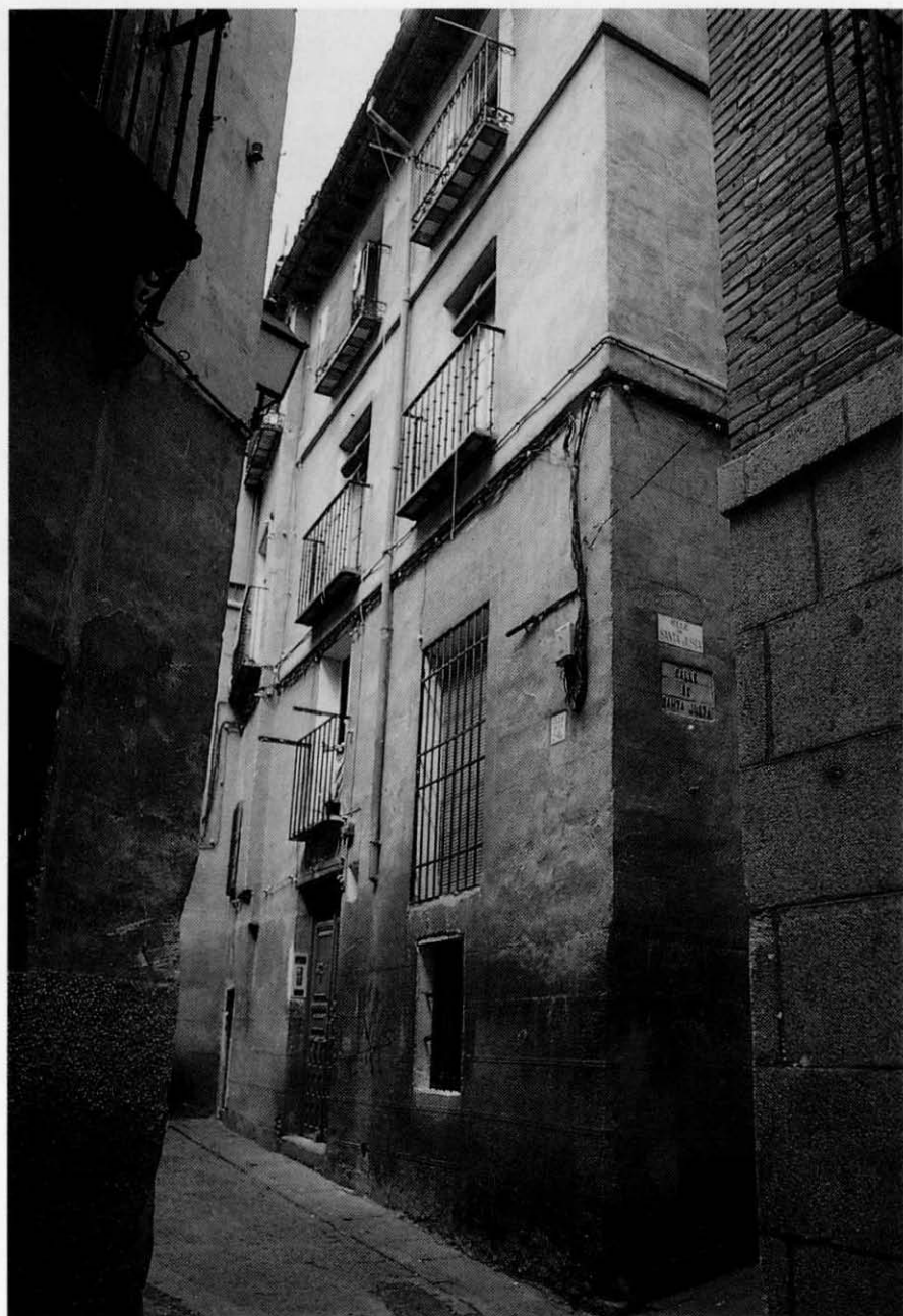
Casa en la esquina de las calles de la Sal y de Santa Justa, en el lugar donde había un cobertizo y la puerta del Alcaná: casa BM-3. J. P., 1993
